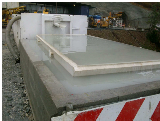
Figura 2 – Transbordo das bacias de decantação do Bifurcador Superior no dia 29/08/2017
